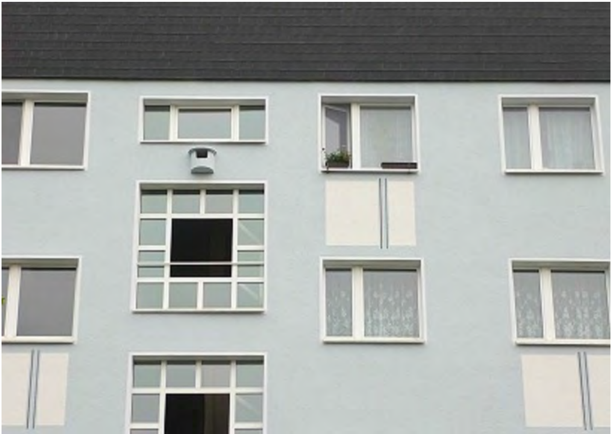
Ein Turmfalkenkasten als Ersatz für ein früher im Treppenhaus durch eine zerschlagene Scheibe zu erreichendes Turmfalkennest.
