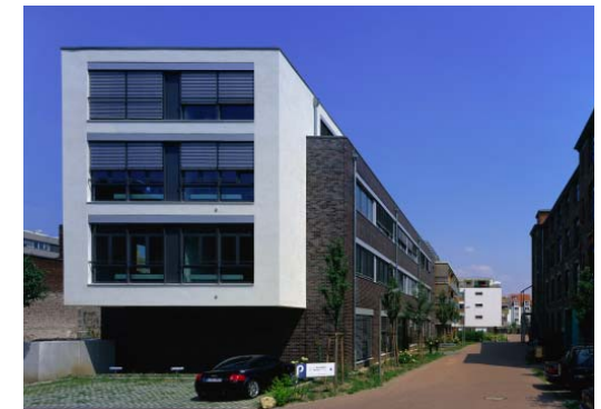
Beispiel Büronutzung Architekten: planquadrat, Darmstadt
