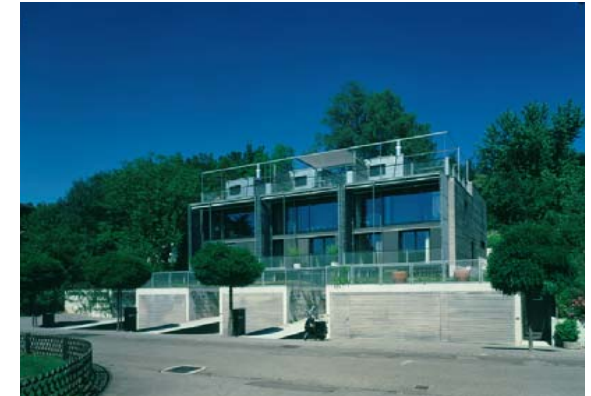
Beispiel Reihenhäuser Architekten: Oertli Weber,
