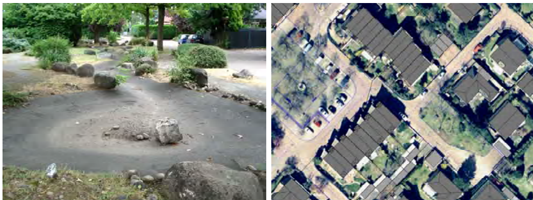
Abbildung 3: Rückbau künstlicher Bachlauf
