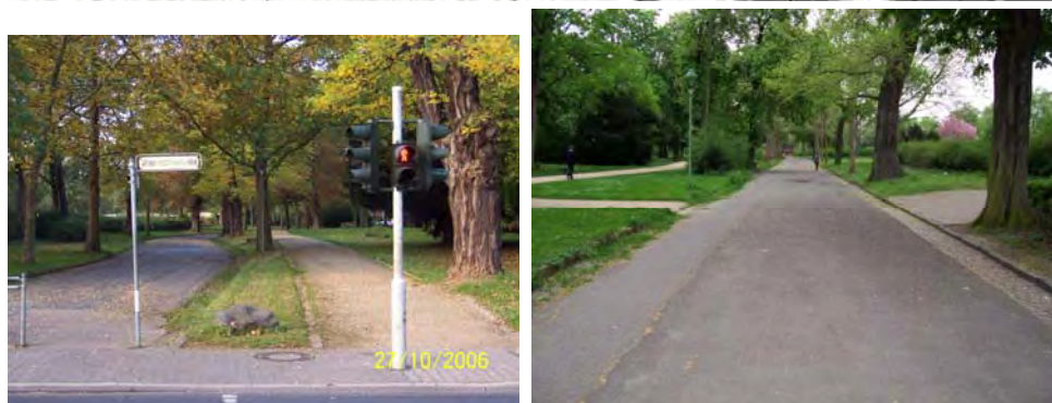
Abbildung 4: Rückbau ehemalige Straße Wallanlagen
