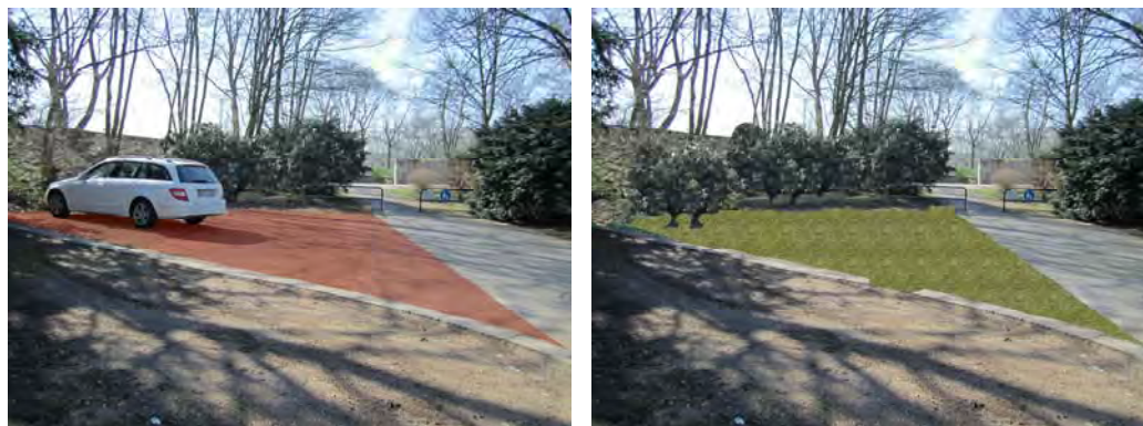
Abbildung 6: Rückbau Aufstellfläche Volkspark
